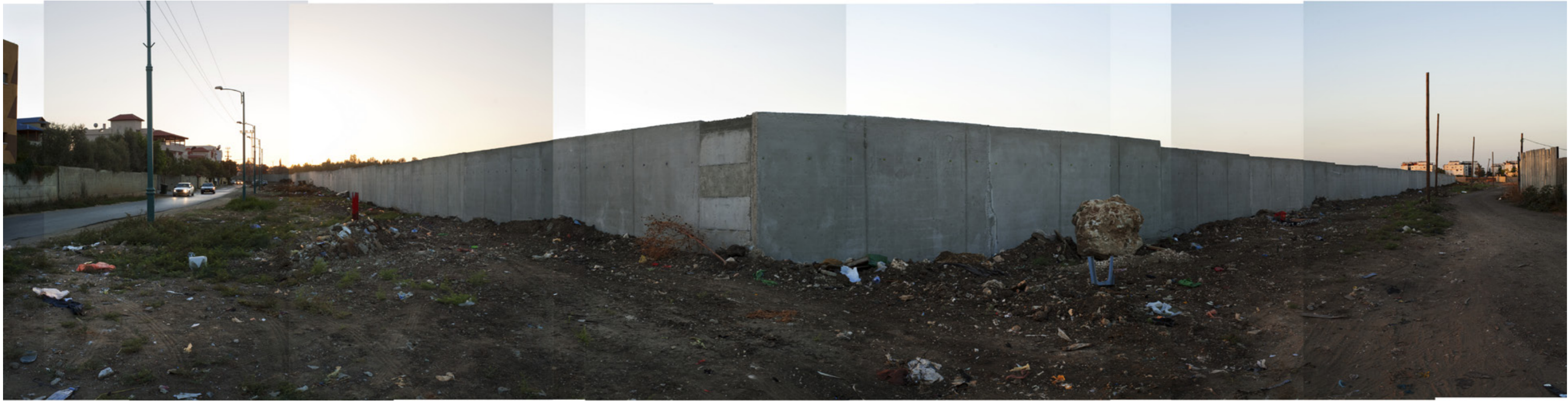
« Interior wall », Lod, Israël, 2010
